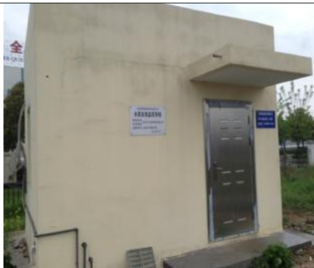
图 4-10 总排口在线监测室
