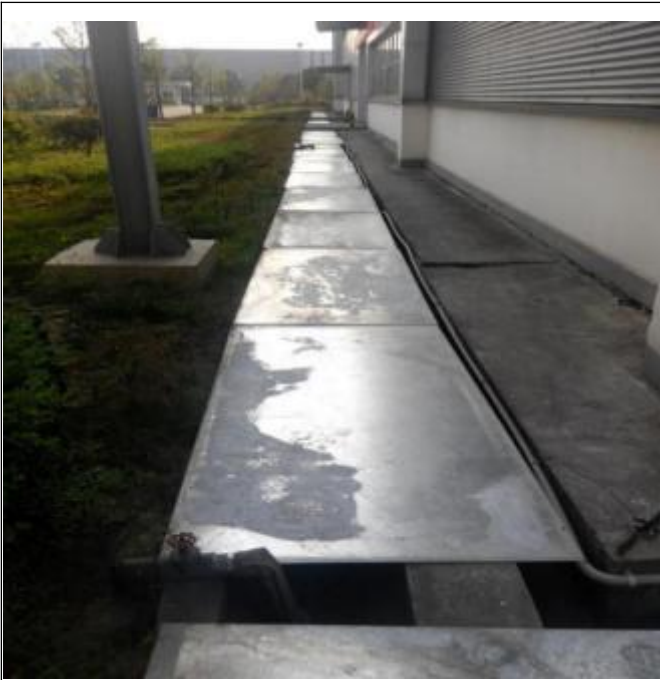
图 4-13 排污管网加盖
