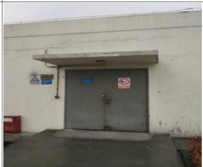
图 4-17 危化品仓库外部
